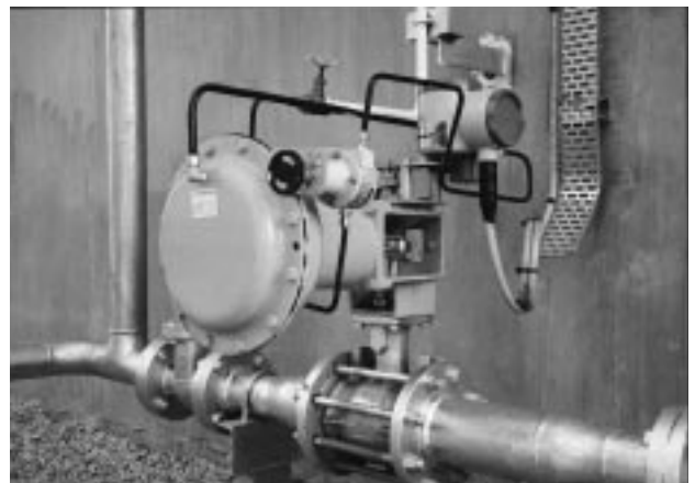
図.4 フィールドバスデバイス(バルブポジション / 調節弁)
