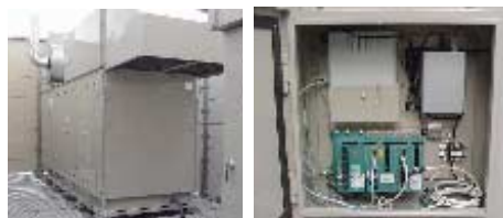
どこでもデータ オンサイト分散型発電設備用 遠隔監視システム
